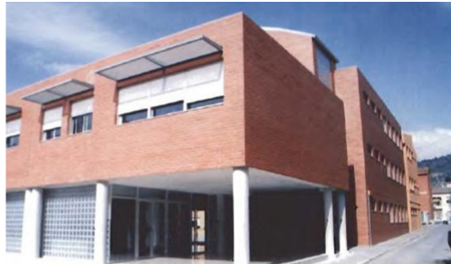
Imagen 12: Entorno del edificio
